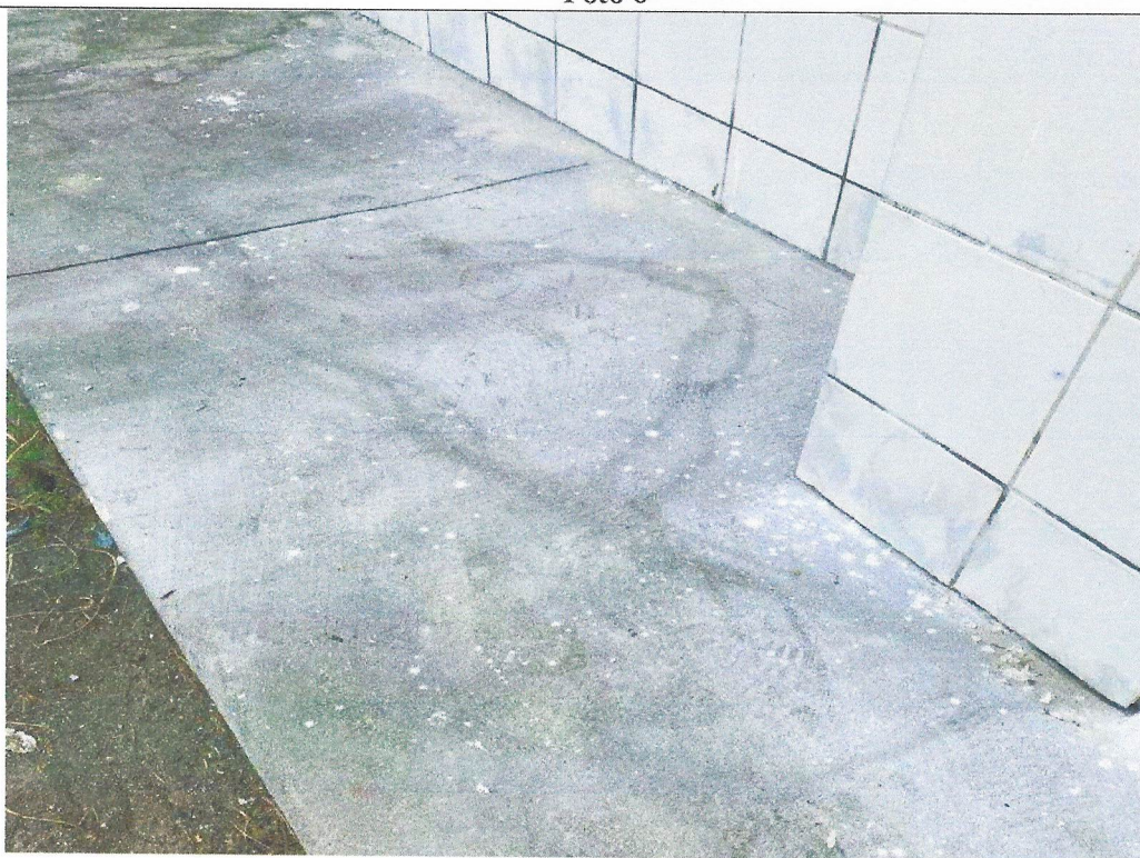
EXECUÇÃO DE PISO CIMENTADO
