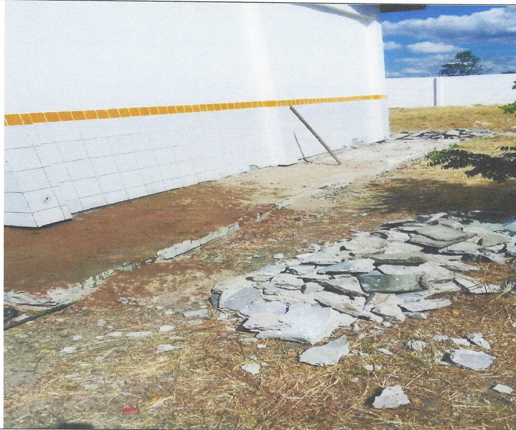
DEMILICÃO DE PISO CIMENTADO
